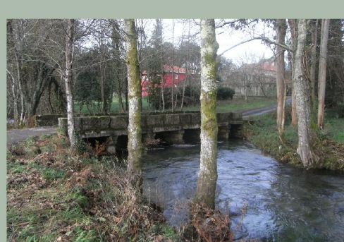
4 Ponte río Laxe-Taragoña Puente río Laxe-Taragoña
